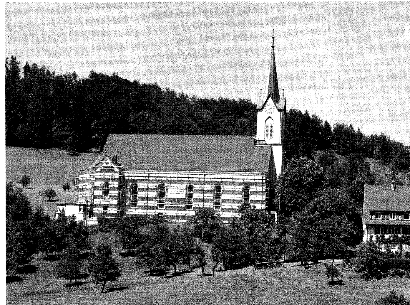
Eingerüstet. Die Sanierungsarbeiten an der Kirche in Oberkirch haben diese Woche begonnen. Foto Tino Briner
