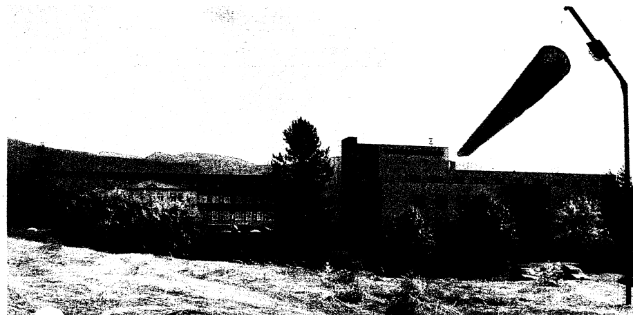
Das L einer Epoche. Die Einsicht, dass vor allem in der Region Schwarzbubenland/Laufental zu viele Akutspitäler bestehen, benötigte viel Zeit. Aber jetzt sind die Würfel gefallen: Alterszentrum statt Akutspital in Breitenbach. Foto Plüss
